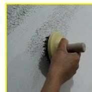
**3** A l'aide du vaporisateur, humidifier la surface uniquement au niveau des motifs réalisés à la taloche, Puis écraser ces mêmes motifs à l'aide de la lisseuse afin d'en atténuer la rugosité. Laisser sécher 8 heures.
